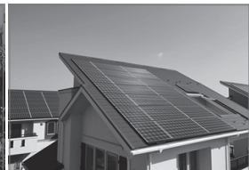
그림 4 각 주택 지붕, 대응량 태양광 판넬
