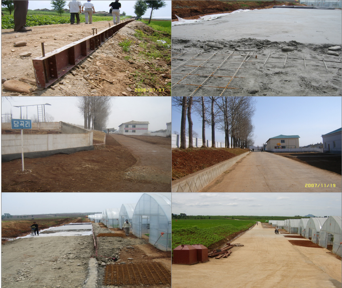
그림 10 | 농로 및 진입로 공사
