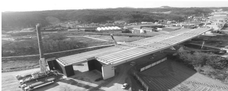
그림 1 BH거더 적용 시공 사례 •
