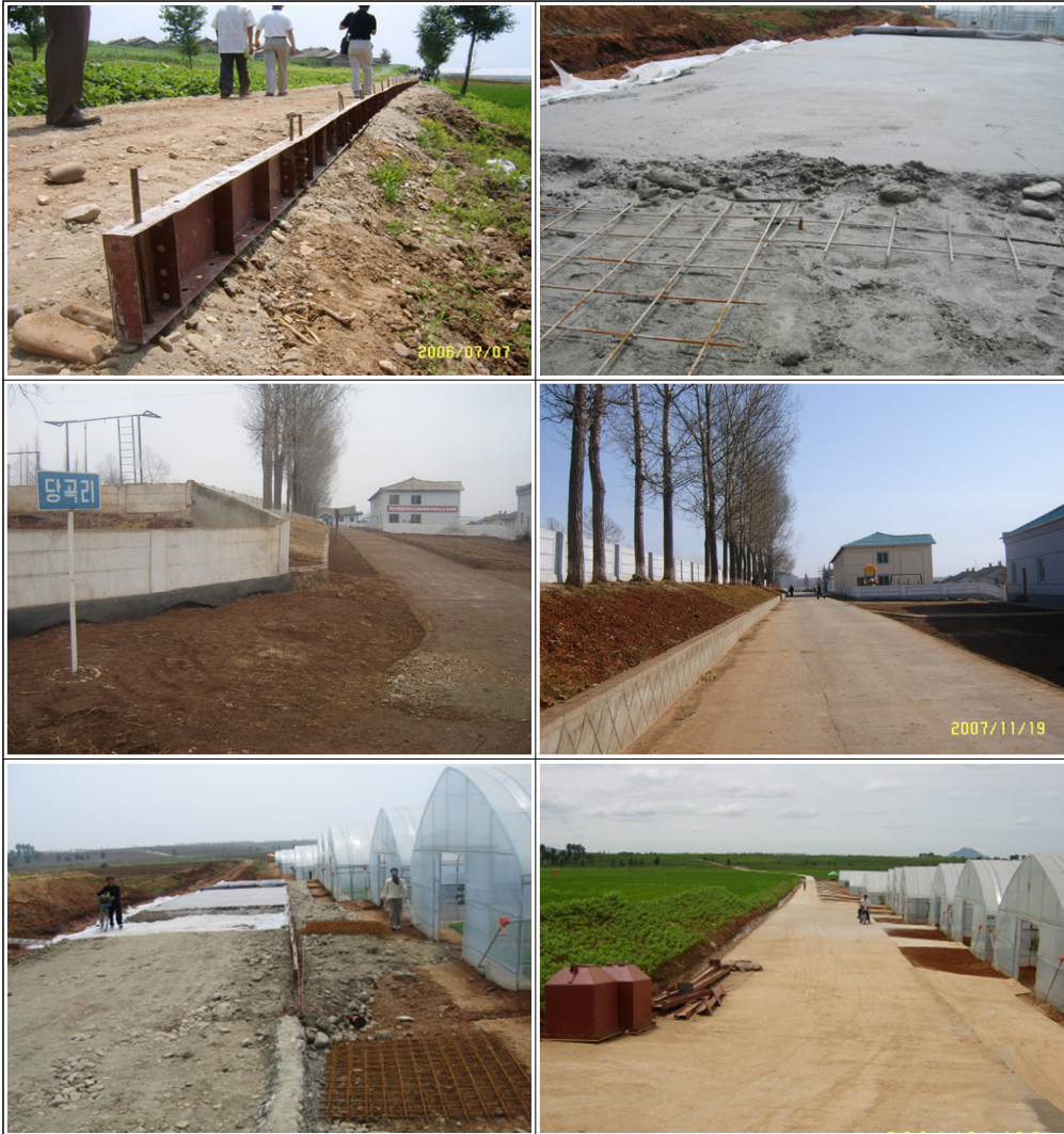
〈그림 3-1〉 농로 및 진입로 공사
