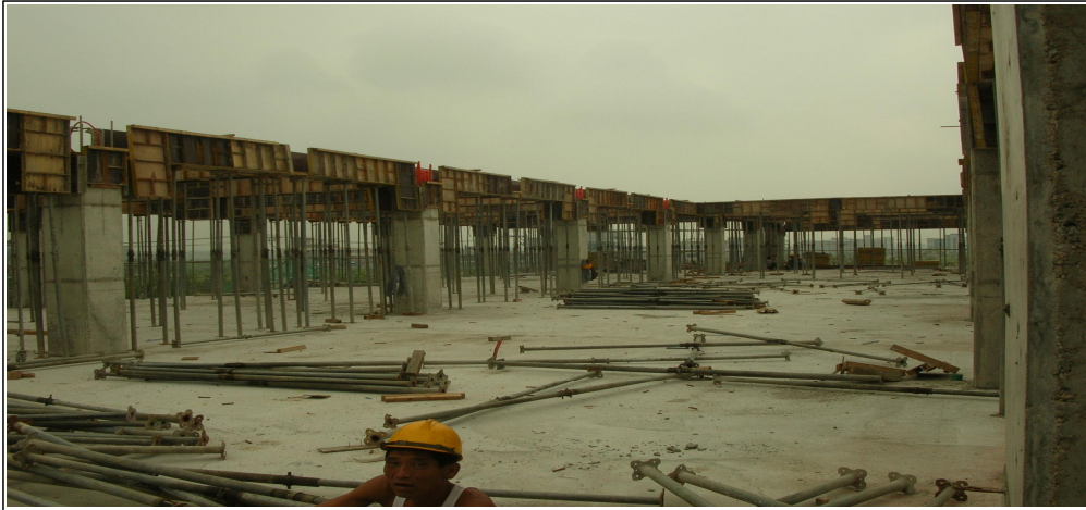
〈그림 3-7〉 개성공업지구 시공 현장
