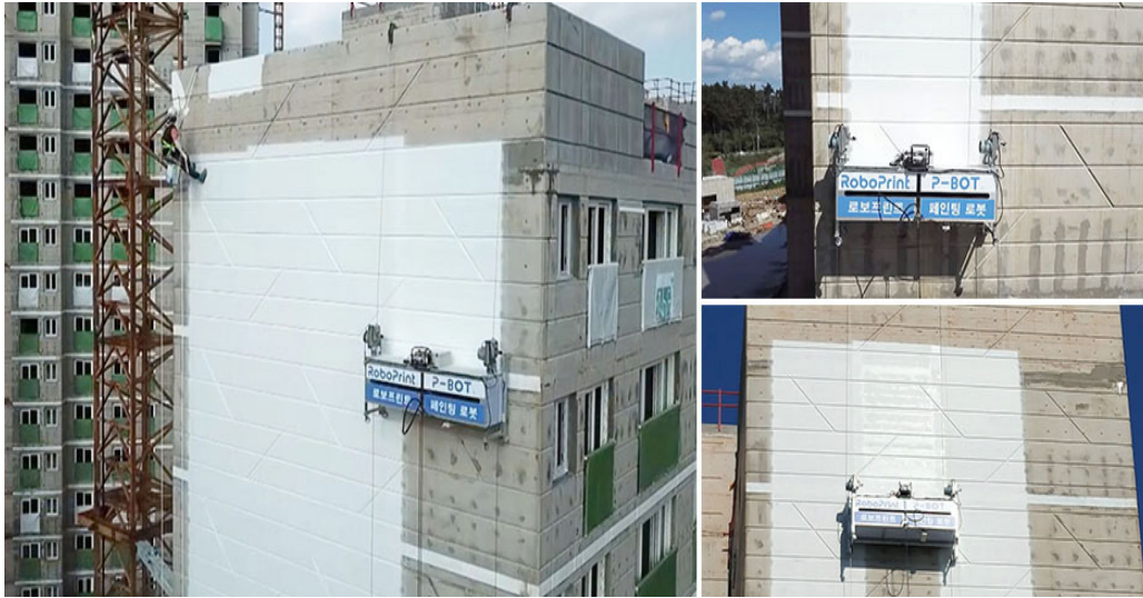
[그림 4-2] 국내 아파트 공사현장 도장로봇 시연
