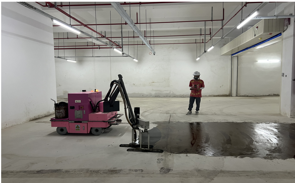
[그림 4-13] 중국 심천의 건축현장에서 사용중인 지능형 시공로봇 2
