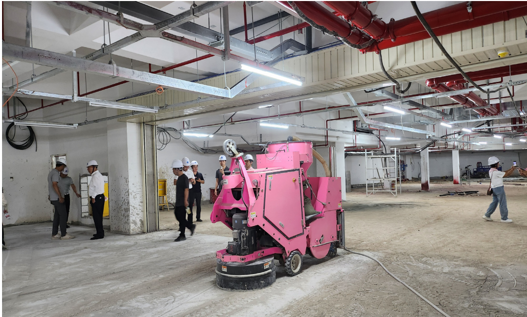
[그림 4-12] 중국 심천의 건축현장에서 사용중인 지능형 시공로봇 1
