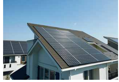
[그림4] 각 주호 지붕, 대용량 태양광 패널
