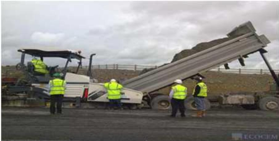
[그림 4-4] 탄소중립 콘크리트 포장 포설 사례(Ecocem 회사)
